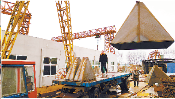
3月25日上午,在临港开发区钢铁制品产业园内,一家钢制品企业正吊装面粉加工设备。据了解,临港开发区钢铁制品产业园已入驻钢材销售和钢制品加工企业32家,年销售额达亿元以上,为周口经济发展助力。 记者 梁照曾 摄
